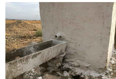
Lavabos tipo abrevadero Aljibe ganadero. "Casa Padilla". La Felipa (Albacete).
